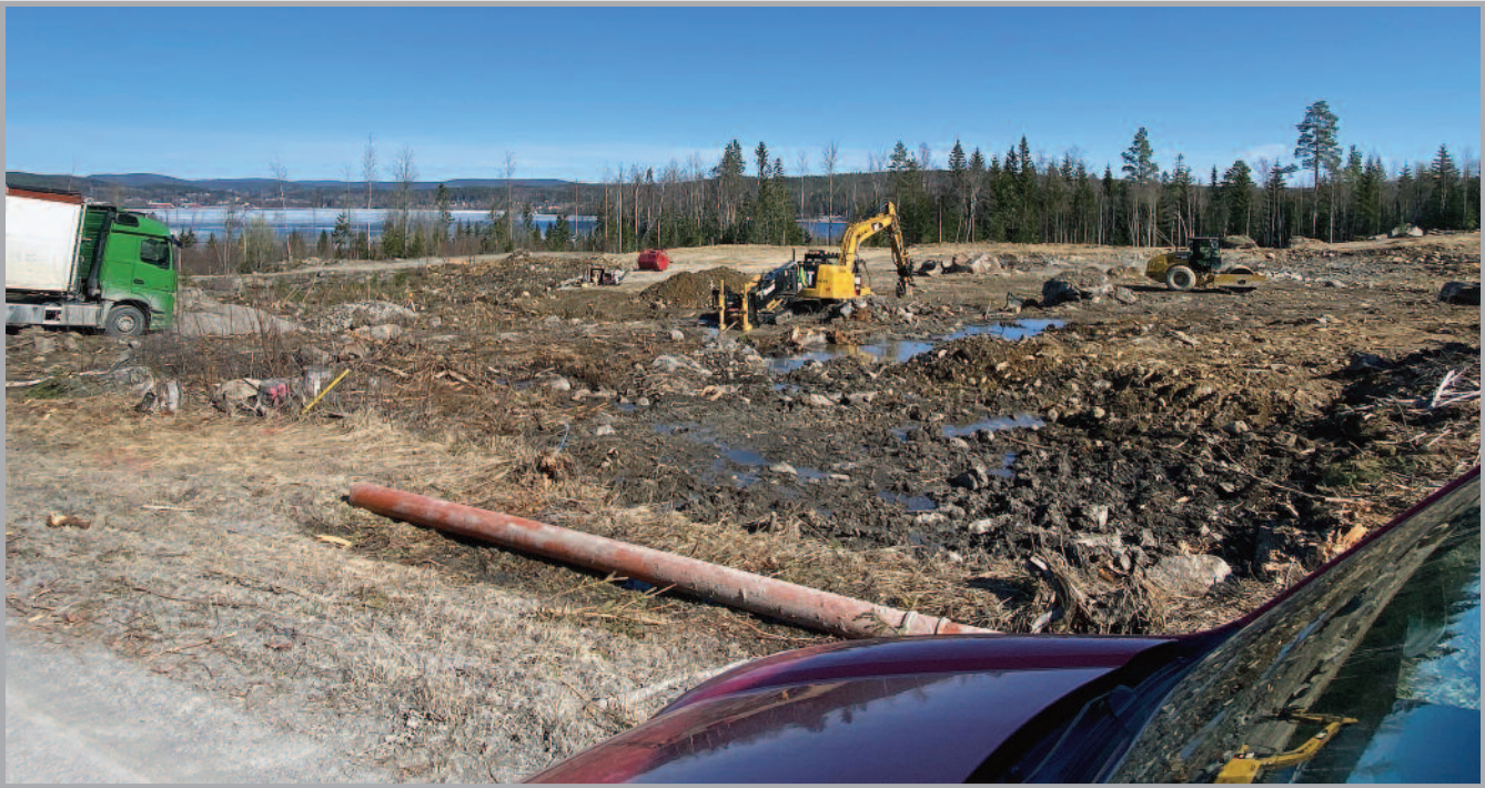
Ett nytt gruppboende byggs i Saltvik.
