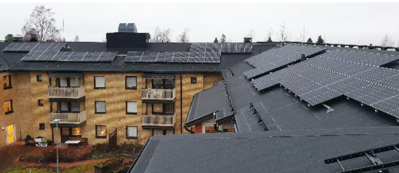
En större installation för solenergi på Koltrastvägen.
