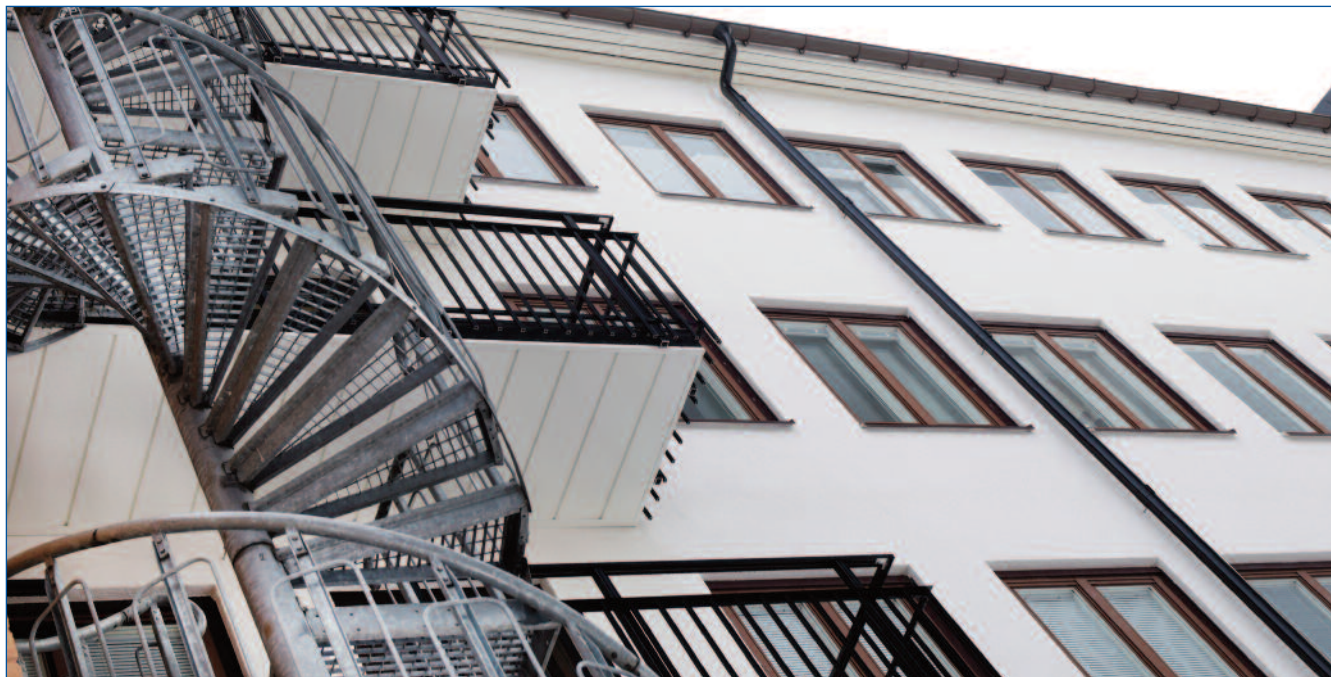
När Estetiska gymnasieprogrammet lämnade Vägmannen byggde vi om till 28 nya lägenheter.
