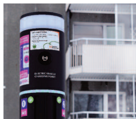
Laddstolpe för elfordon på Herrgårdsvägen.
