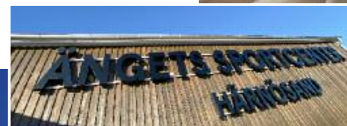
Ängets Sportcenter blev en ny modern idrottsanläggning där Ängevallen legat sedan 1923.
