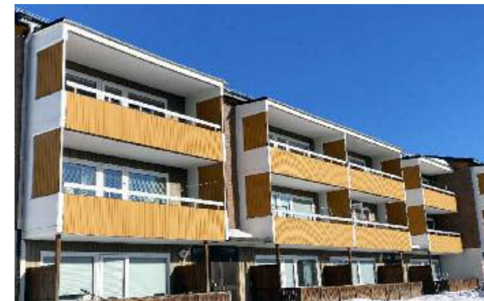
Under 2025 fortsatte arbetet med byten av fönster och altandörrar i Gånsviksdalen.
