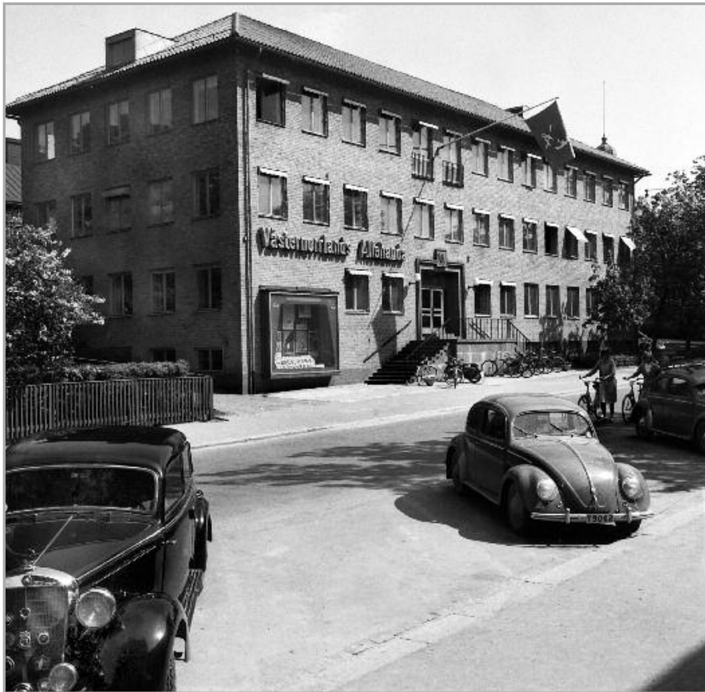
Teologen 12 på Nybrogatan 13 uppfördes för Västernorrlands Allehanda år 1948 och är sedan 2002 kontor för AB Härnösandshus. Under 2020 har ett nytt styr- och övervakningssystem installerats och det möjliggör bättre styrning och minskad energiförbrukning.
