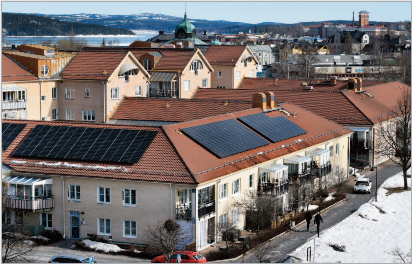
Torsvik 3 har försetts med solpaneler.
