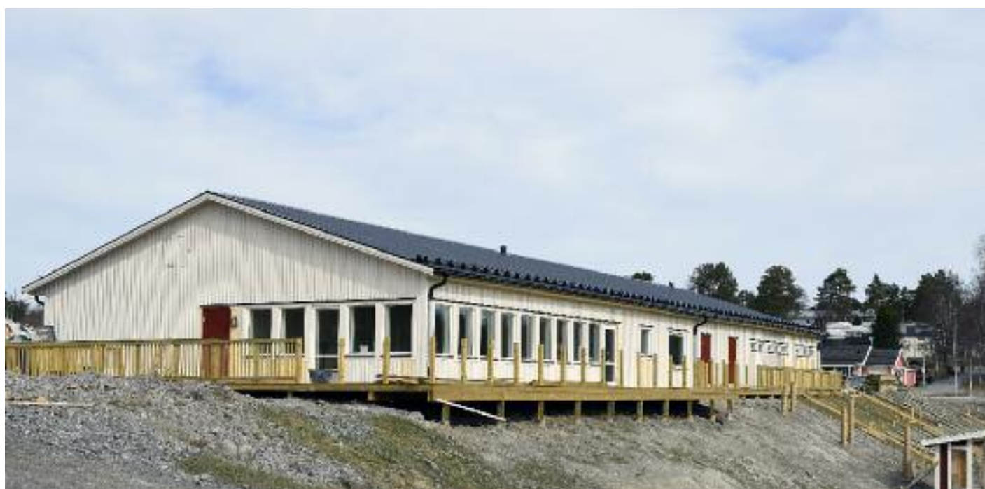
En helt ny byggnad uppförs vid Bondsjöanläggningen.
